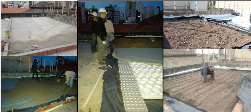
Imagen 3: Las distintas capas de la terraza. Izquierda arriba nuevo hormigón y abajo zócalos para delimitar el espacio. Centro las distintas capas; membrana impermeable, barrera anti raíz, manta de retención y drenaje, filtro de tela. Derecha arriba sustrato y abajo instalación del sistema de riego.
